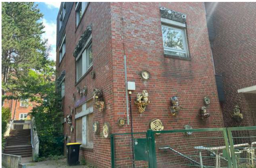
Sieht so ein Leuchtturm aus? Im Katastrophenfall ja! Mehr dazu auf Seite 6 (Foto: anschuma)
